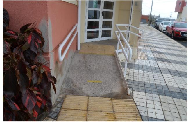
Imagen: E.2.1 Rampa y escalones aislados.
